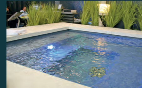
QUELLEINLAUFDÜSEN nehmen positiven Einfluss auf die Atmosphäre in Ihrer Wohlfühloase, indem sie das Wasser bewegen
