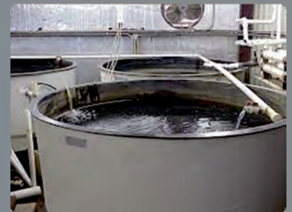
Vasche di contenimento
